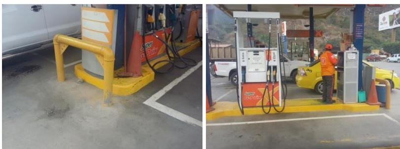
Estructura fundida para compensar las protecciones en U
